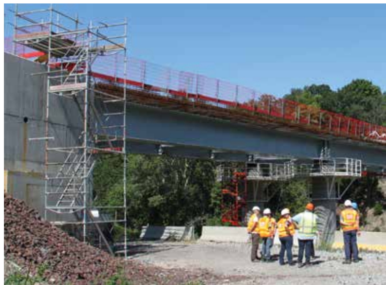
↑ La réparation des ouvrages d'art
