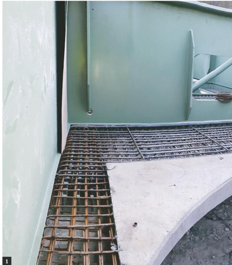
qui sont traditionnellement plus épaisses car la dalle y reprend moins bien les efforts exercés sur la structure. Jusqu'à présent, cette particularité obligeait les ingénieurs à rajouter du ferrailage et du béton afin de conférer une plus grande stabilité à l'ensemble de la structure. « La double action mixte permet de s'affranchir de ce renfort », résume Jean-Christophe Carlès.
