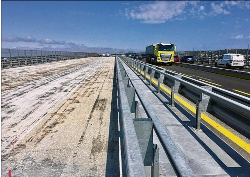
À gauche, l'ancien enrobé a été totalement enlevé. Jusqu'au 8 août, le travail consiste à en gommer les multiples aspérités, avant de mettre en place une nouvelle couche, identique à celle posée l'an passé (à droite).
