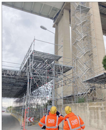
Alors que l'on s'affaire au balisage sur le pont, les échafaudeurs assemblent pièces par pièces d'impressionnants échafaudages. / PHOTOS P.S.
