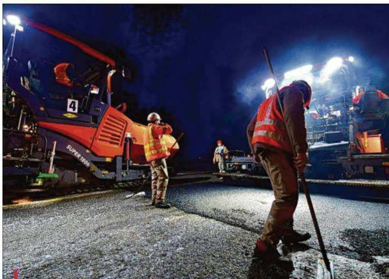
La première couche d'enrobé de l'A501 a été réalisée à chaud avec un "finisher", en utilisant un granulat de 14 millimètres.
