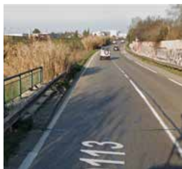
La RD113 au niveau du franchissement de La Cadière. Sur le côté droit, la présence du mur de protection phonique limite les possibilités d'élargissement
