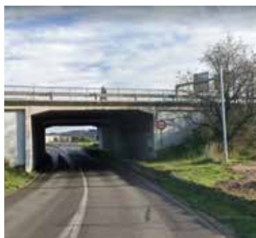
Le passage de la branche ouest de la RD113 sous A7
