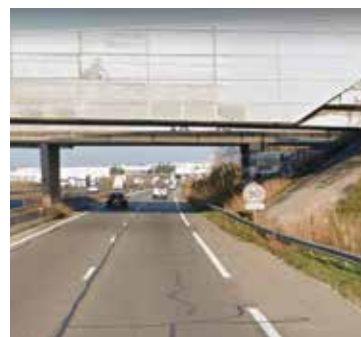
La RD113 sous le Pont d'Anjoly qui interdit toute possibilité d'élargissement
