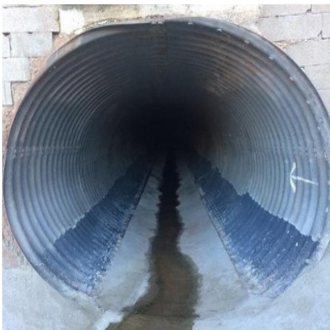
Fig : Rétablissement des écoulements sur le nouveau radier. A noter la remise en peinture sur les revanches afin de protéger les zones où la perte en galvanisation d'origine a été détectée (bandes gris foncé).
